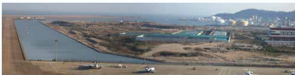
Figura 3 - Situação de deposição do Aterro para Resíduos de Materiais de Construção
