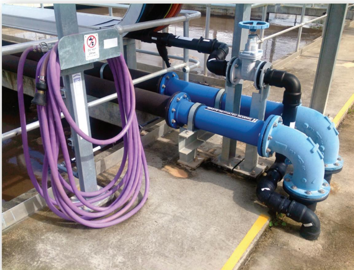
以明顯標識區分自來水管與再生水管
