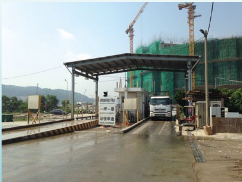
圖二 建築廢料堆填區地磅系統
